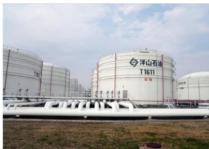
上海洋山港油库的石油储罐
